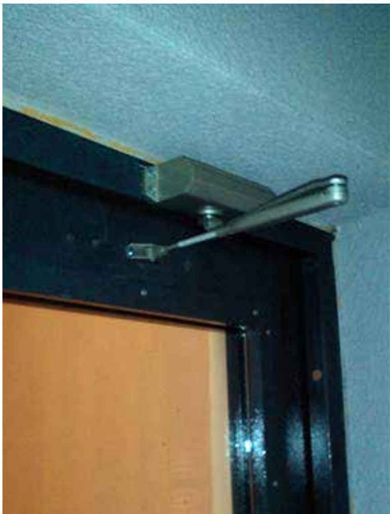
На фото: Корпус 3,подъезд 1, этаж 2. Выход с балкона на пожарную лестницу. Восстановлен дверной доводчик
