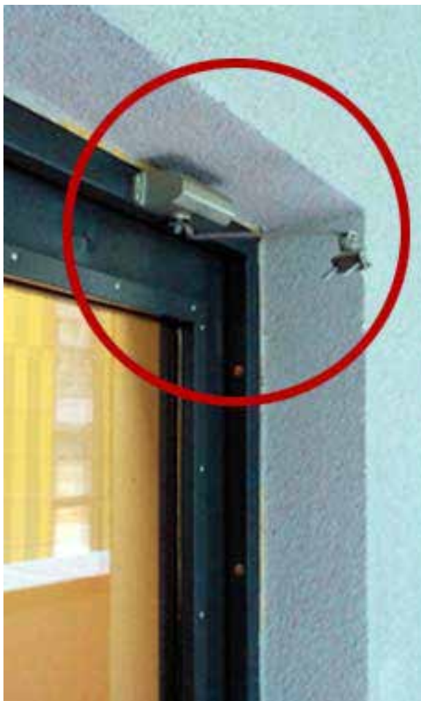
На фото: Корпус 3,подъезд 1, этаж 2. Выход с балкона на пожарную лестницу. Восстановлен дверной доводчик
